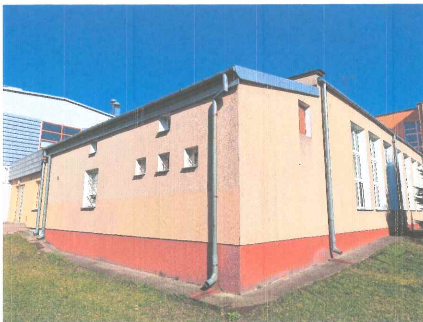
Zdjęcie 9. Elewacja południowo-wschodnia (sala gimnastyczna).
