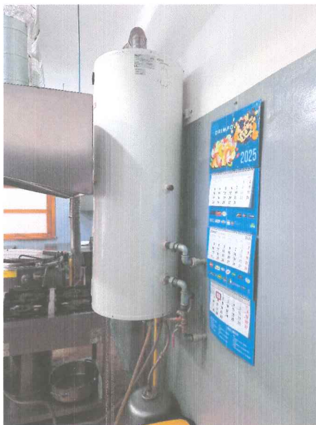
Zdjęcie 14. Gazowy podgrzewacz ciepłej wody użytkowej w kuchni.
