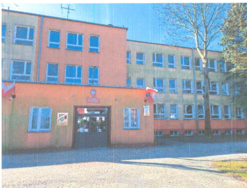
Zdjęcie 2. Elewacja północna.
