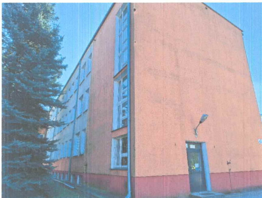
Zdjęcie 4. Elewacja zachodnia.
