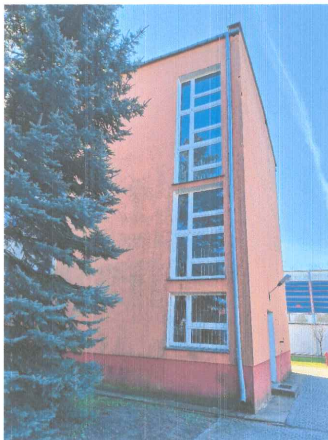
Zdjęcie 3. Elewacja północna.
