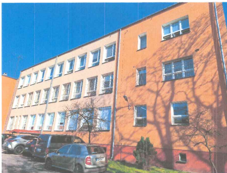
Zdjęcie 8. Elewacja południowa.
