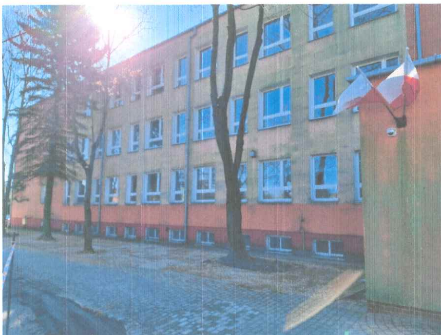
Zdjęcie 1. Elewacja północna.
