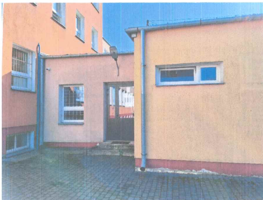
Zdjęcie 5. Elewacja zachodnia.
