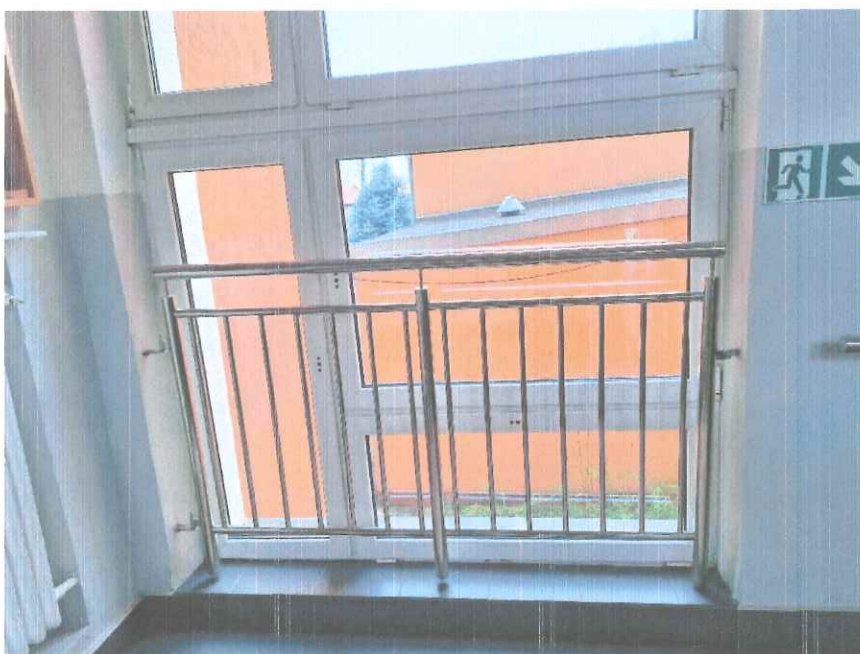
Zdjęcie 12. Okna zewnętrzne.
