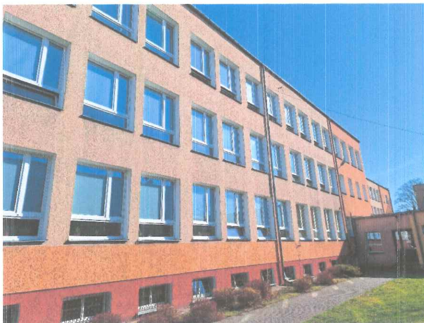
Zdjęcie 7. Elewacja południowa.
